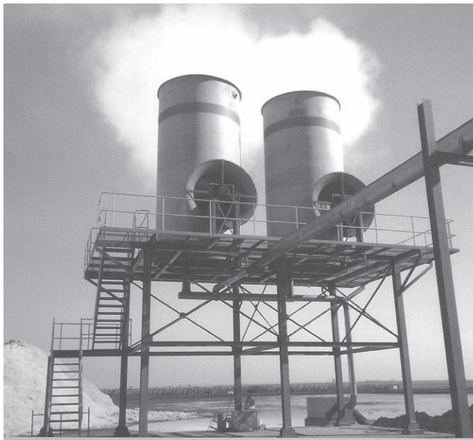
Figura 33 Torre de resfriamento de vinhaça.
