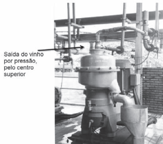
Figura 15 Vista de uma centrífuga instalada e em operação.
