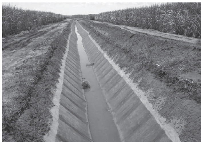
Figura 36 Canal para o transporte de vinhaça revestido com manta asfáltica.
