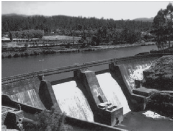
Figura 3.3 Barragem de gravidade.
